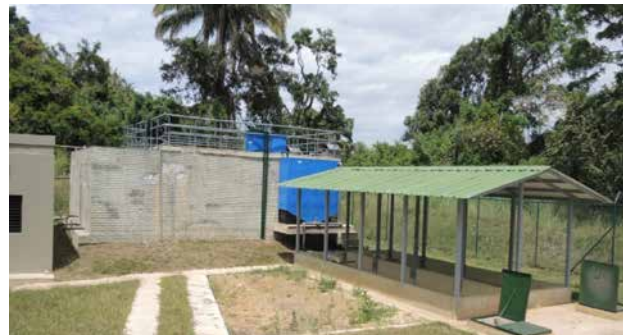
Proyecto La Gran Reserva, Anapoima. Planta de tratamiento de aguas residuales.
